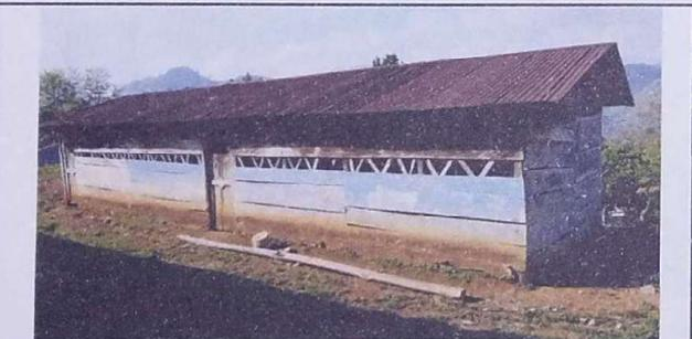
Foto 5: La estructura de techo requiere susutitucion
